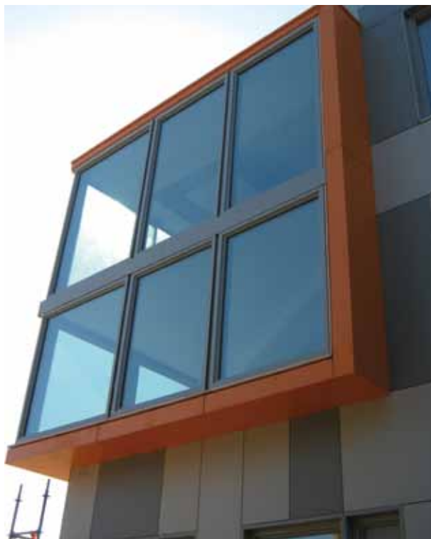
Les menuiseries et vitrages sélectionnés par Energelio garantissent un maximum d'apports solaires et un minimum de déperditions surfaciques.
