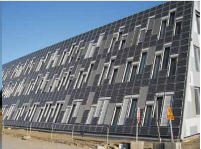
L'un des deux bâtiments neufs : DPAS, avec sa façade rideau inclinée qui a à la fois une fonction solaire passive (vitrage) et une fonction solaire active (capteurs photovoltaïques).
