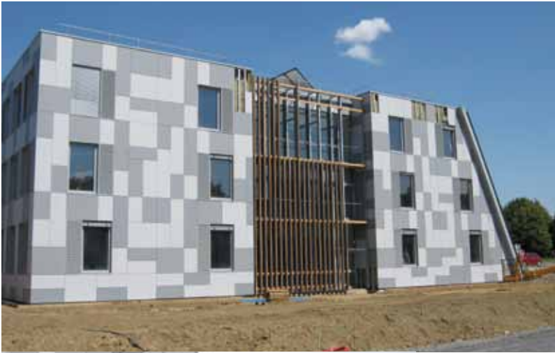
L'un des deux bâtiments neufs : DPAS, avec sa façade rideau inclinée qui a à la fois une fonction solaire passive (vitrage) et une fonction solaire active (capteurs photovoltaïques).
