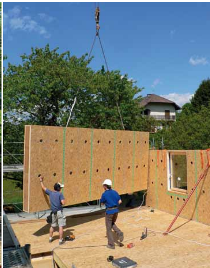
Les murs à ossature de 30 cm d'épaisseur ont été fabriqués et montés en atelier par Etamines et livrés sur site avec leurs menuiseries. Les trous que l'on aperçoit sont les ouvertures ménagées pour l'insufflation de ouate de cellulose sur site. Ils sont ensuite bouchés et étanchéifiés.
